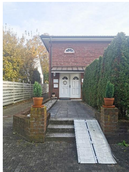
Rückseite des Hauses – Praxiseingang
